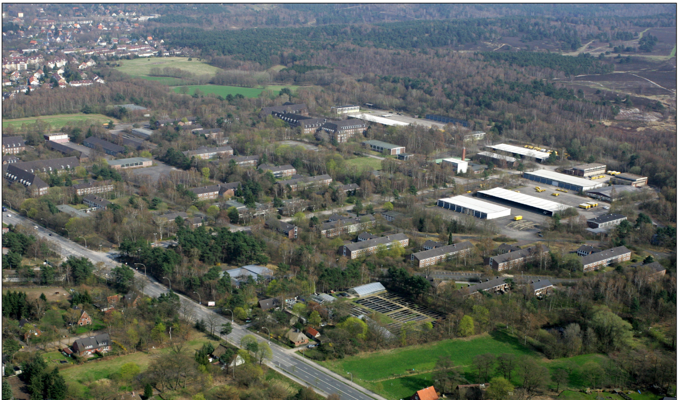
Abb. 6 / Luftbild - Gelände der Röttiger-Kaserne
