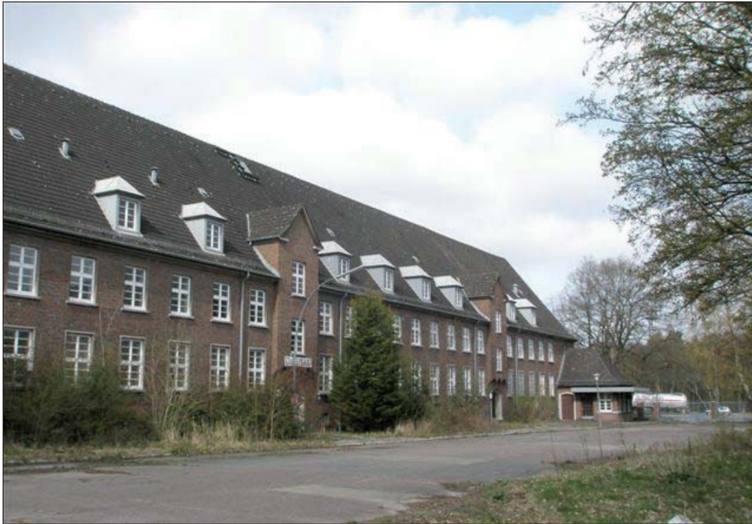
Abb. 7 / Blick Richtung Norden auf LOS 1 mit Wächterhäuschen
