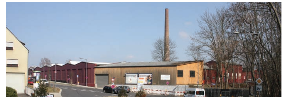
Der Schornstein in Richtung Nordosten
