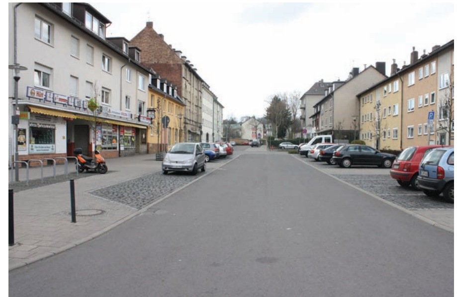
Engelhardstraße in Richtung Süden
