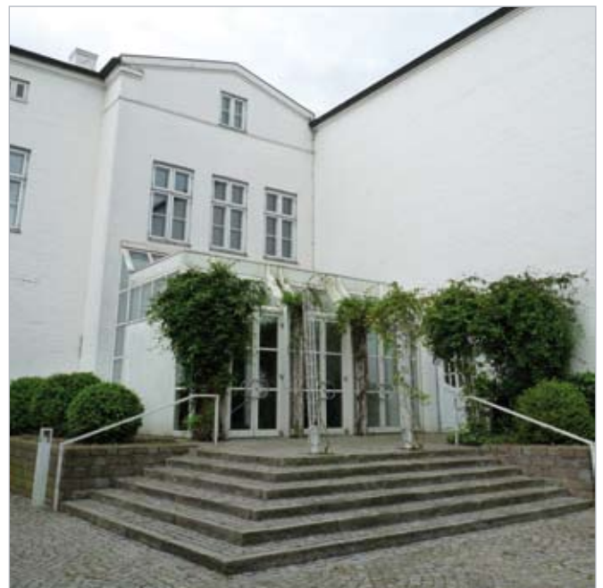
Abb. 27 | Historisches Rathaus, rückwärtige Treppenanlage
