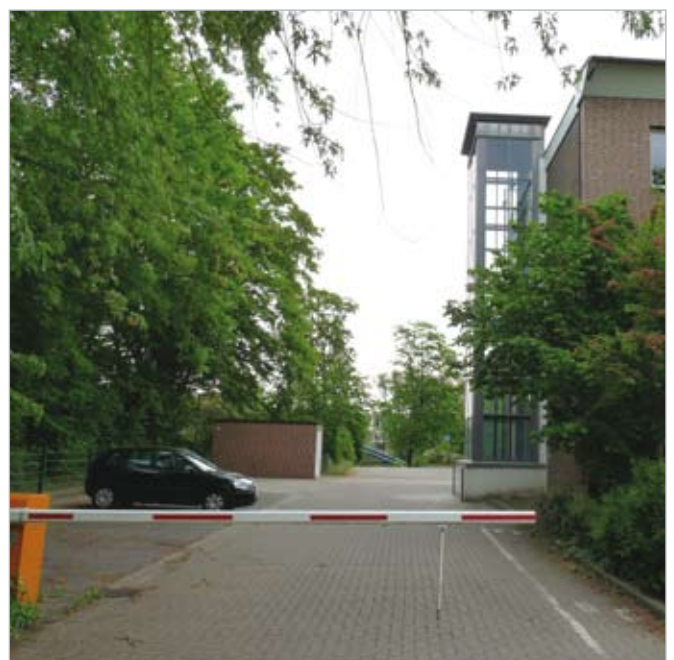
Abb. 32 | Zufahrt zu den Parkplätzen hinter dem Amtsgericht
