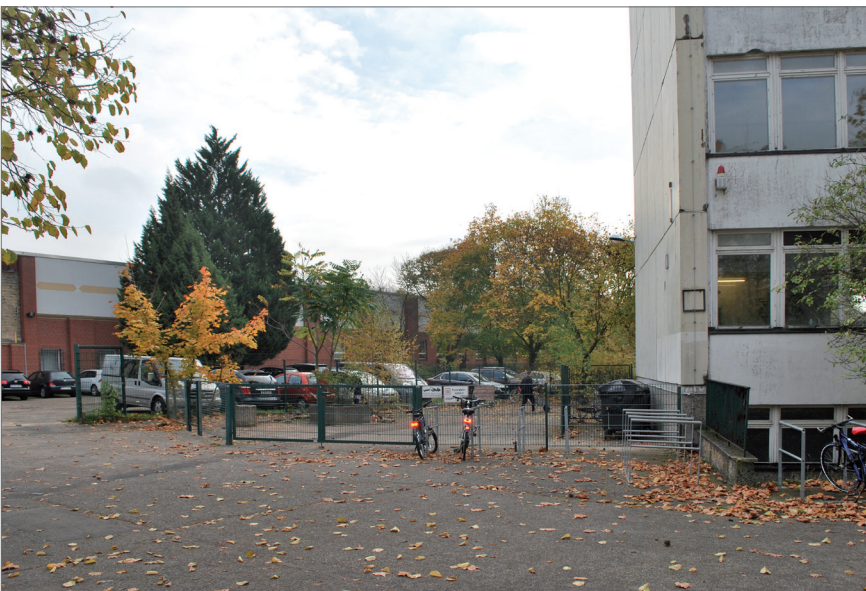
Blick von Westen auf den Hauptzugang auf das Schulgelände im Norden-Osten.
