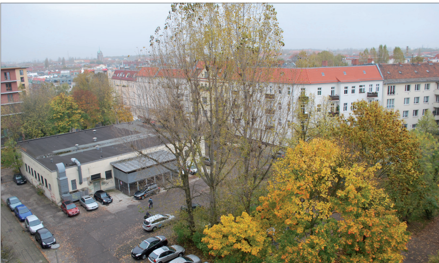
Blick nach Westen aus dem 9. Geschoss des Wohn-Plattenbau auf die Kaufhalle, das Schulgebäude schließt rechts an.
