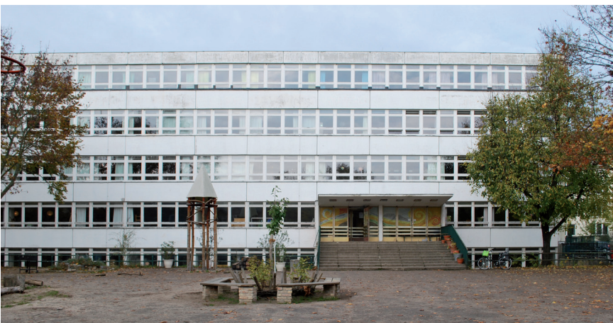
Abb. 06: Teilansicht Osten vom Schulhof auf den Haupteingang
