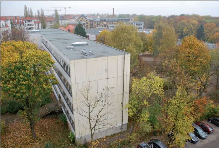
Blick nach Norden aus dem 9. Geschoss des Wohn-Plattenbau auf das Schulgebäude, rechts der Schulhof, das wellenförmige Dach der Turnhalle ist durch die Bäume zu erkennen.
