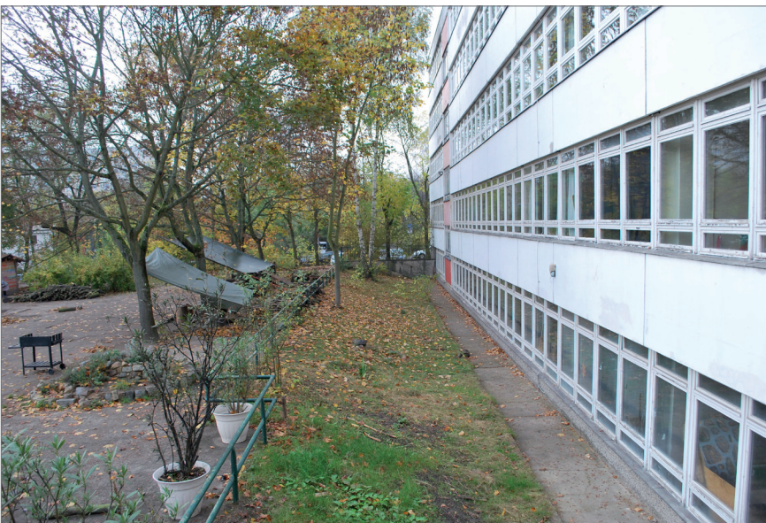
Blick von Norden entlang der Ostfassade mit Böschung zum UG.
