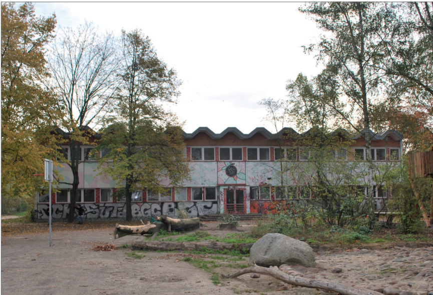
Blick vom Haupteingang (Westen) über den Schulhof auf die Sporthalle.
