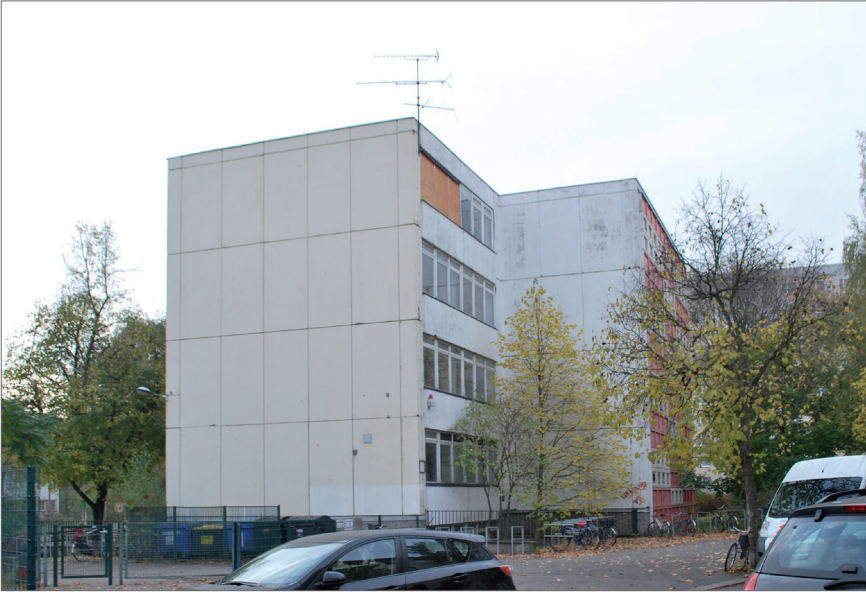
Blick auf die nördliche Brandwand der Schule, links der Hauptzugang auf das Schulgelände.
