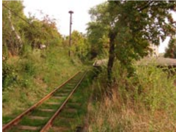
Gleisanlage der Museumsfeldbahn
