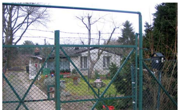
F 6 Kleingartenlaube am unbefestigten Weg östlich des Anstaltsgeländes, Blickrichtung Osten
