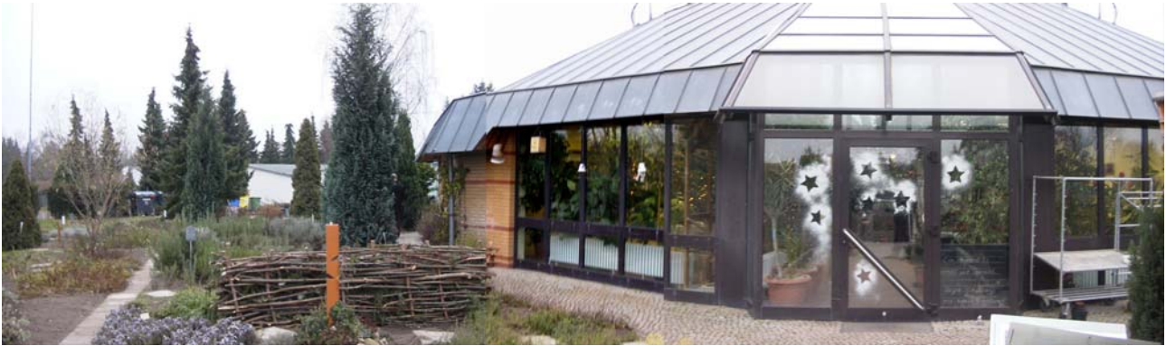
F 30 Eingang zum anstaltseigenen Laden auf der Ostseite des zu erhaltenden Gewächshauses
