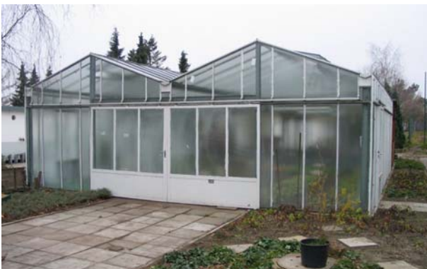
F 34 Kleines Gewächshaus, südlich an das zu erhaltende Gewächshaus angrenzend, Blickrichtung Westen
