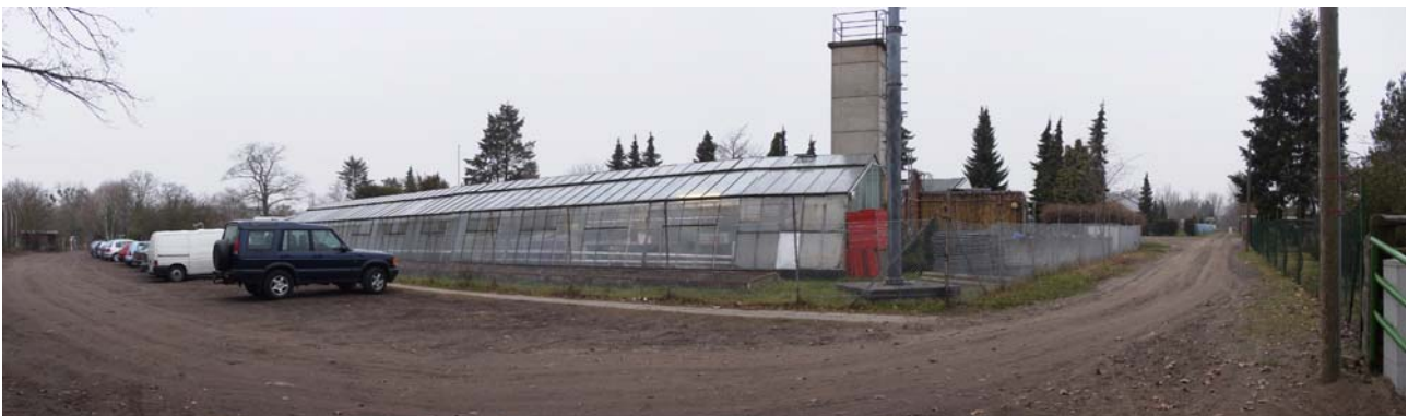
F 24 Südöstliche Ecke des Wettbewerbsgrundstückes mit unbefestigtem Erschließungsweg
