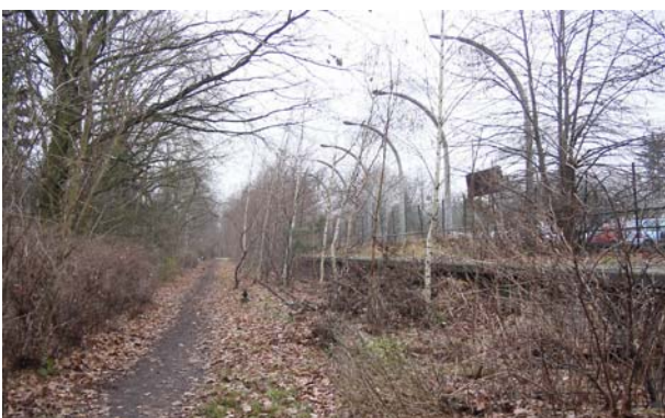
F 5 Stillgelegter S-Bahnhof Zehlendorf-Süd südlich des Anstaltsgeländes, Blickrichtung Westen
