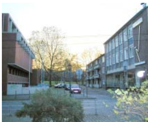
Blick in die Zitadellstraße aus nordöstlicher Richtung
