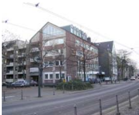
Blick in die Innenstadt vom Oberdorfer Platz aus östlicher Richtung
